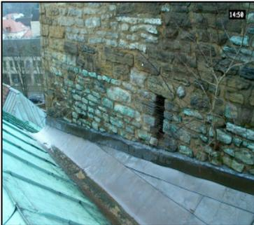
Am Neujahrmorgen drang Schneeschmelzwasser an dieser Stelle ein und verursachte eine Wasserfahne an der Wand im Dom. Die Schadensursache wurde provisorisch beseitigt. Dabei stellte sich heraus, dass nicht nur der Anschluss des Daches an die Außenwand undicht ist, sondern die
